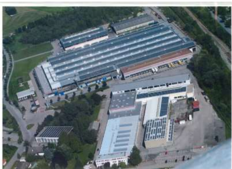
Maximale Abdeckung mit Fotovoltaik-Modulen im Werk Landau an der Isar
